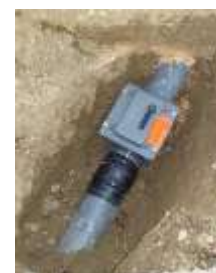
Batardeau, obturation du vide sanitaire et clapet anti-retour
