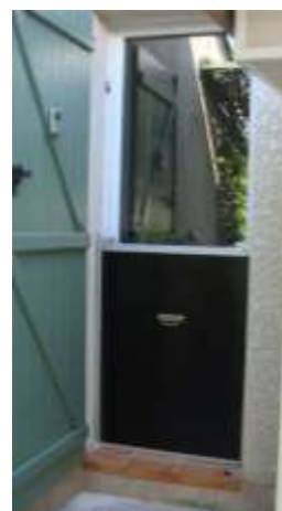
Batardeau, obturation du vide sanitaire et clapet anti-retour
